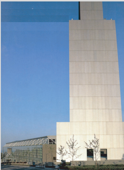
チタンクラッド鋼でできたタワー
