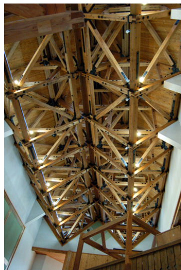
エントランス天井
