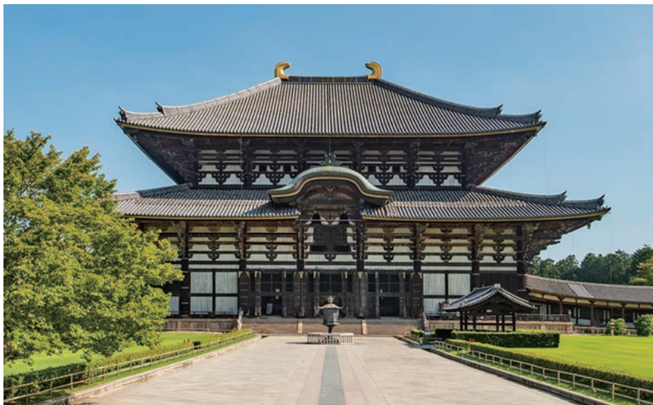
国宝：東大寺大仏殿（金堂）寄棟造（桁行5間・梁間5間）本瓦葺、一重裳階付・正面軒唐破風付
